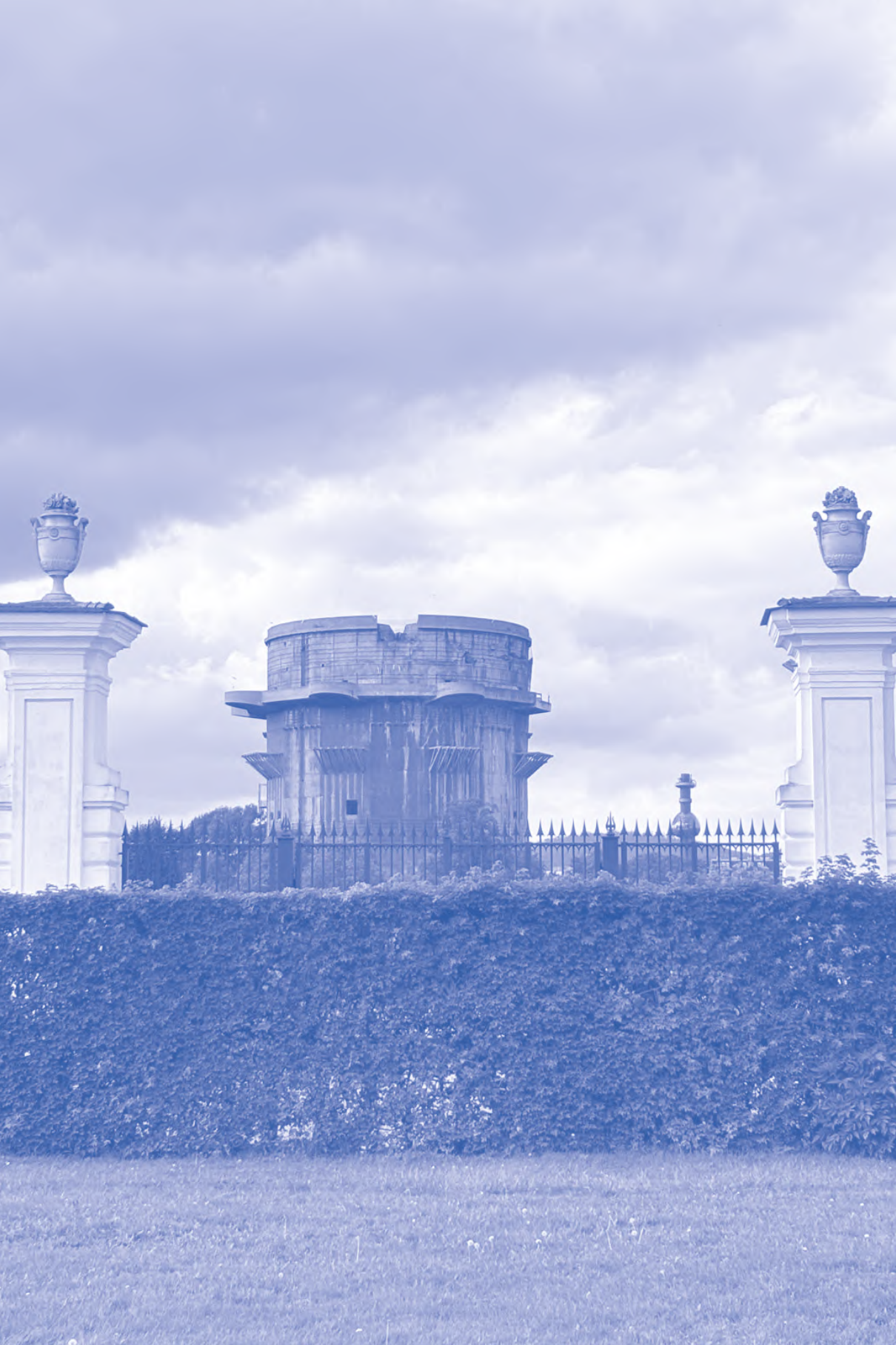
01 Blick auf den Flakturm
